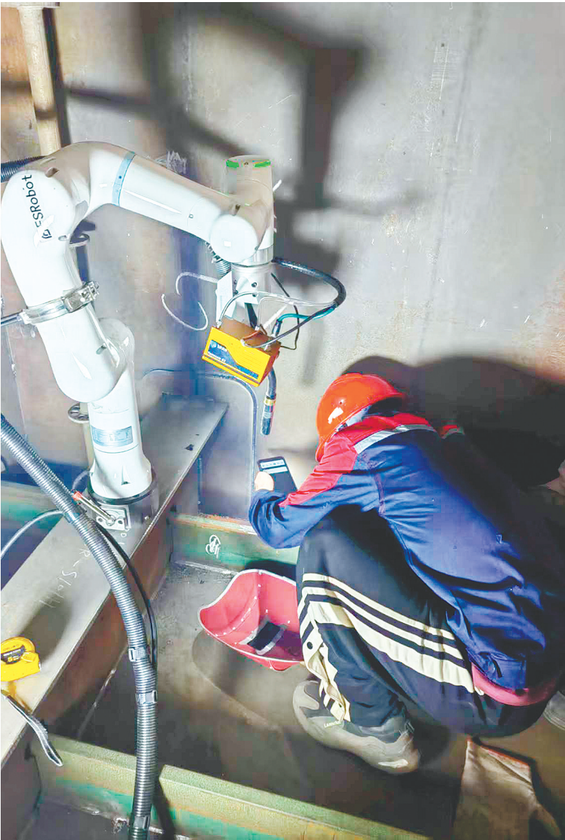
焊接机器人小巧轻便,接上电源,便可对着钢板开始焊接。
