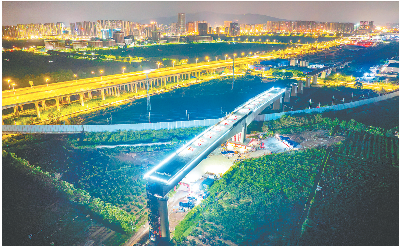
昨日凌晨,珠肇高铁跨南车路特大桥T构桥顺利完成转体作业。
