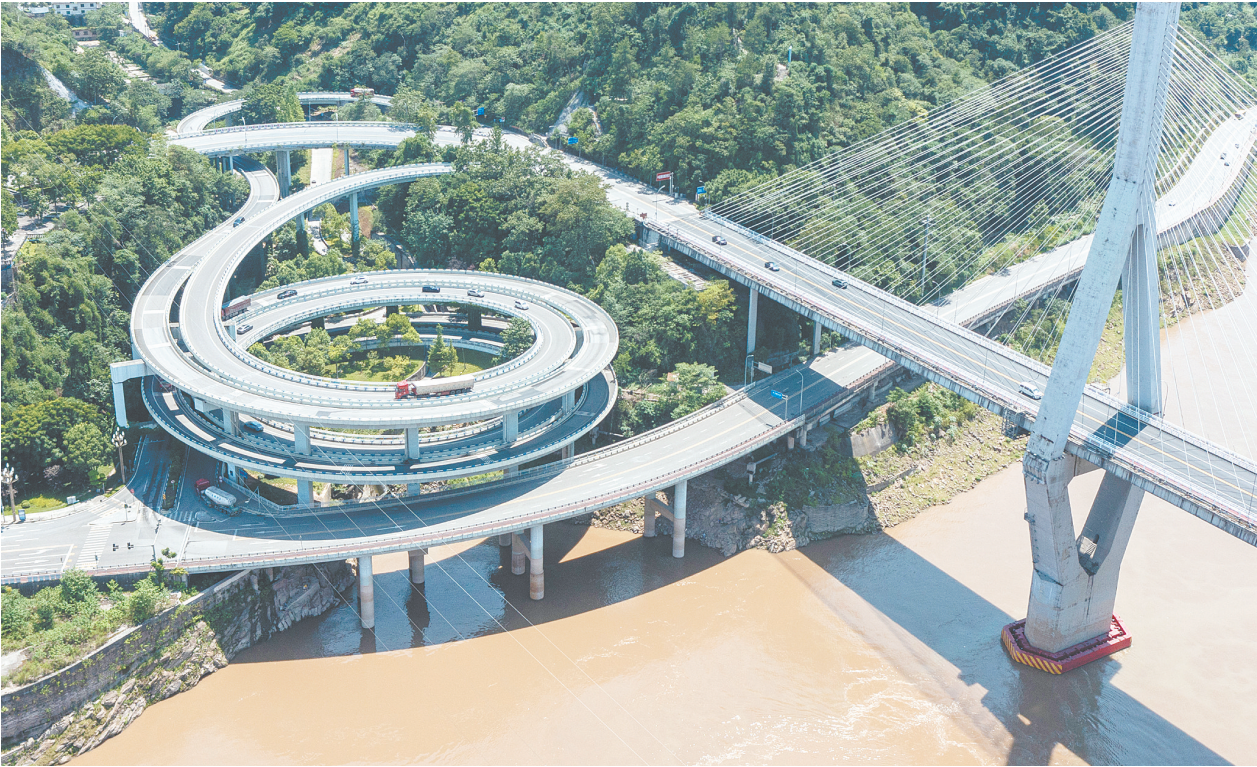
如今，荔枝园外的运输方式已然变迁。图为重庆市涪陵区涪陵长江大桥桥头的公路立体交通（无人机照片）。新华社发
