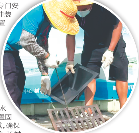
▲工人把“四防”装置固定在下水口。
