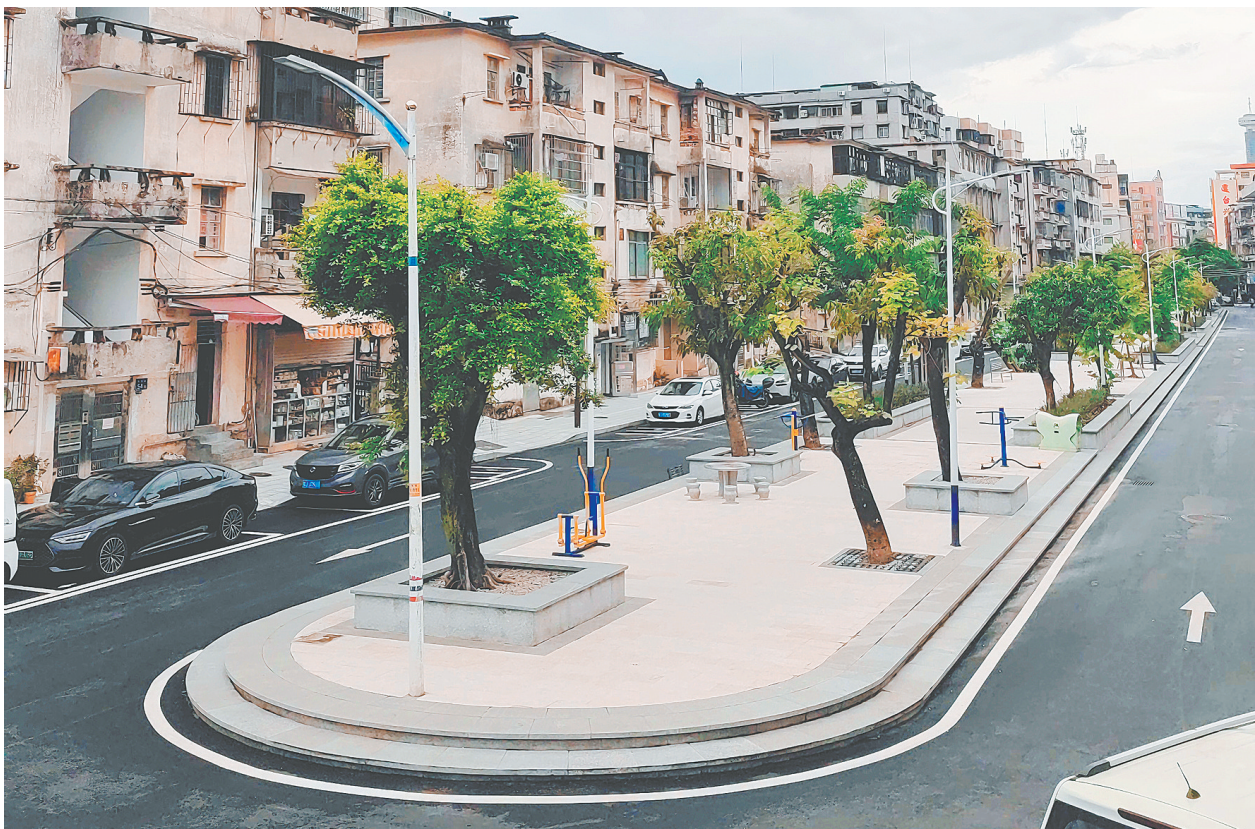
自2021年起，台城街道稳步推进27个老旧小区升级改造。图为改造后的平湖路小区。
