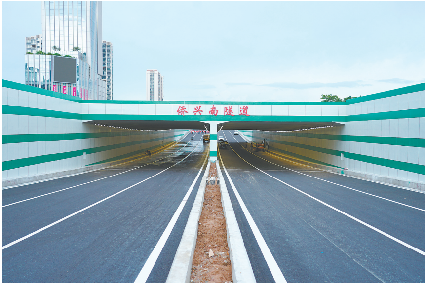
侨兴南隧道的贯通将为新会区路网通行效率带来巨大提升。
