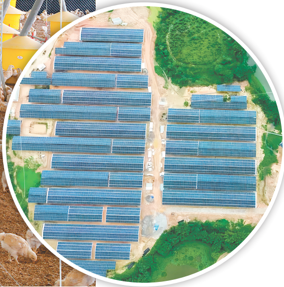
▼光伏板发的电不仅满足养鸡场自身需求，还能并入电网，产生经济效益。 金鸡镇供图
