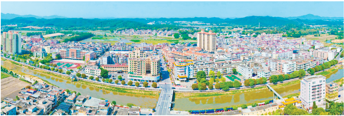
沙湖镇大力推动美丽圩镇建设。图为圩镇新貌。沙湖镇供图
