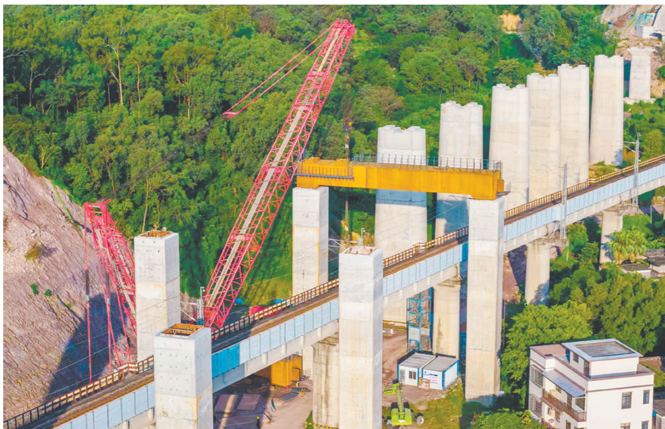
施工人员历经3小时完成了钢盖梁的起吊、位移、转体、微调与安装等工序,为后续架梁与铺轨施工奠定了坚实基础。
