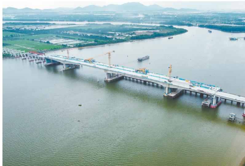
潭江特大桥主跨顺利合龙。
