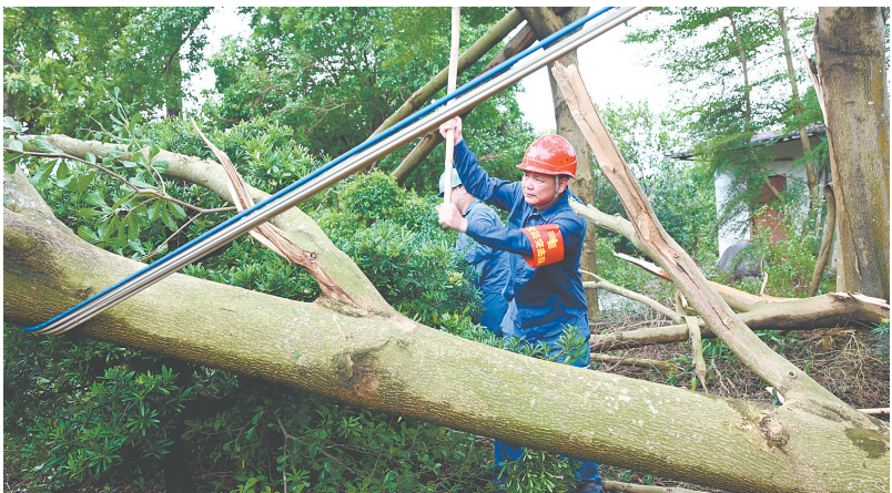
9月25日,南方电网广东江门恩平供电局君堂供电所抢修人员清理树障。
