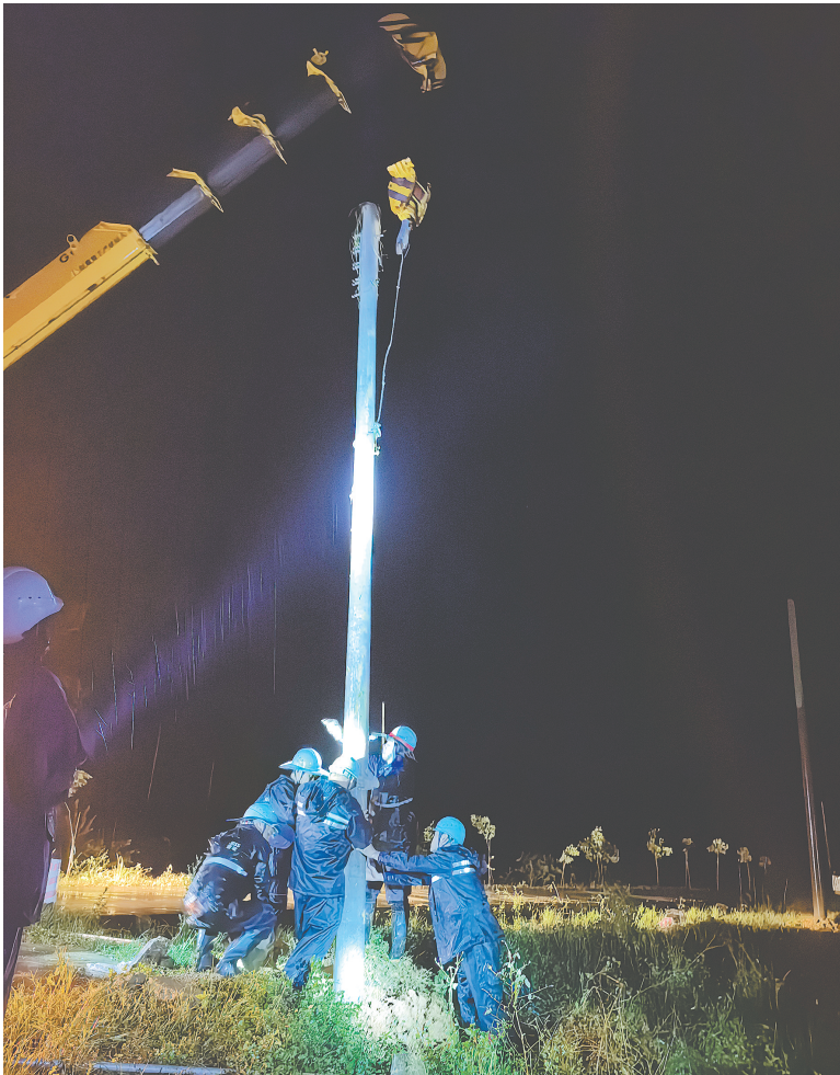
9月24日,南方电网广东江门台山供电局台城供电所抢修人员在夜色中,借着应急灯微弱的光线,组立新电杆、更换断裂的低压导线。
