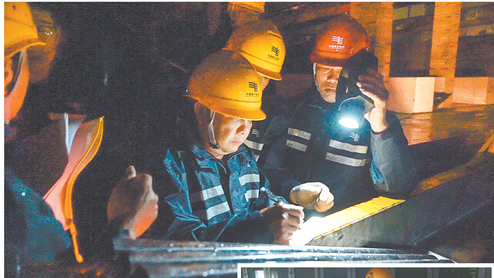
南方电网广东江门台山供电局下川供电所工作人员在雨中制订计划,通宵抢修。9月25日凌晨5点,下川岛墟镇恢复供电。
