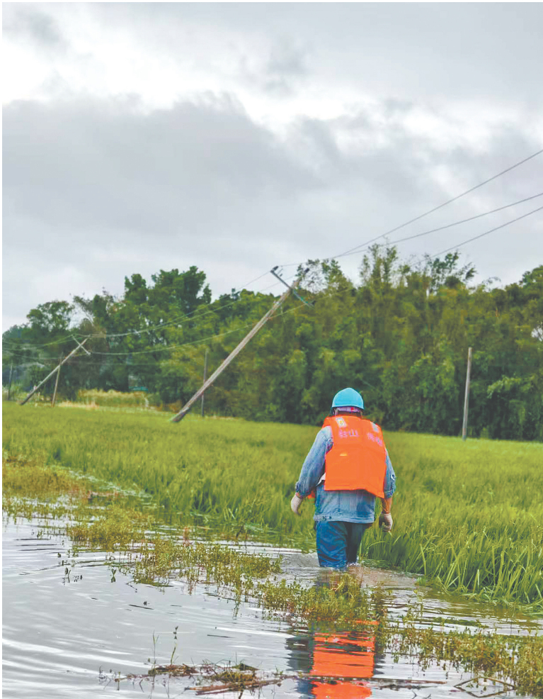
9月25日,南方电网广东江门台山供电局端芬供电所运维人员对被台风刮倒的供电线路开展抢修作业。
