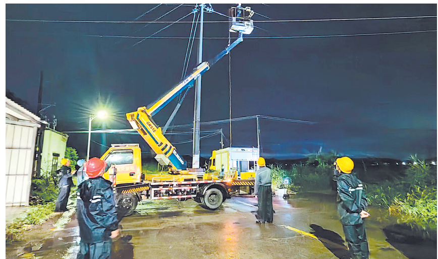
台风过后,南方电网广东江门新会供电局抢修人员马不停蹄开展现场抢修。
