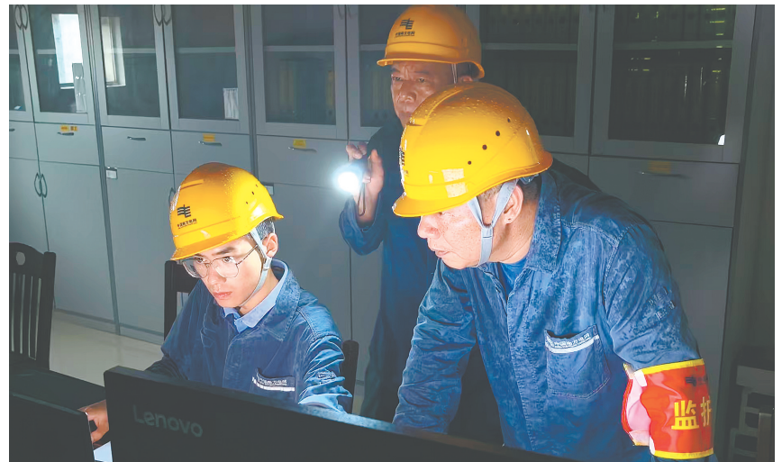
9月24日下午,川岛区域进入12级风圈,恶劣天气冲击下,110千伏下川变电站工作人员全力开展抢修。
