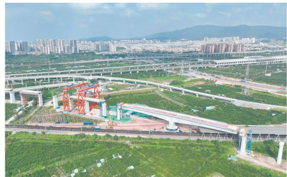
转体过程中,项目团队创新运用5G技术,构建了基于BIM与数字孪生的动态智能监控平台,为安全平稳转体提供了可靠的数据支撑。
