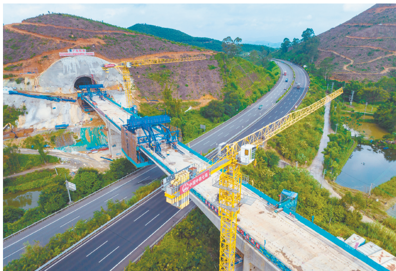
本次合龙的跨 G94 高速公路大桥总长 314.5 米,采用钢管柱支架法现浇施工,实现了安全高效施工与保障公路畅通的双重目标。
