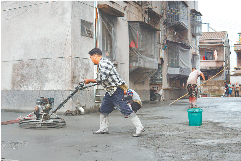
公益圩平湖路老旧小区进行硬化化处理及下水道改造。
