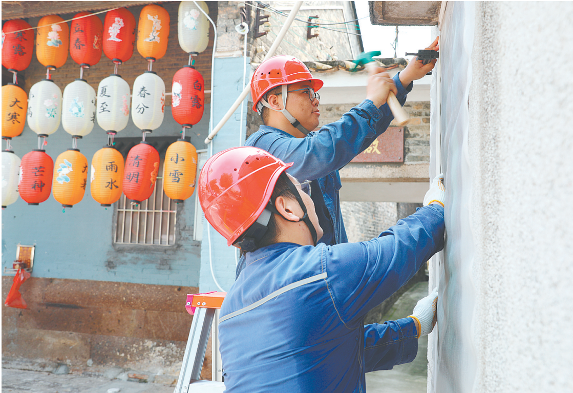
供电人员正在为居民安装纱窗。
