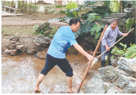
周解兮在排水沟清理淤泥。
