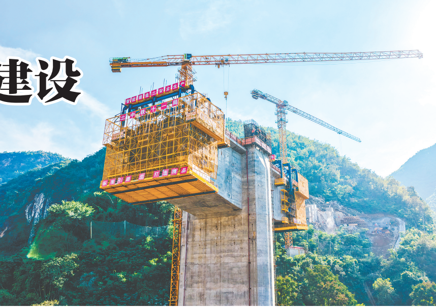
西渝高铁嘉陵江特大桥建设现场(无人机照片)。 新华社发
