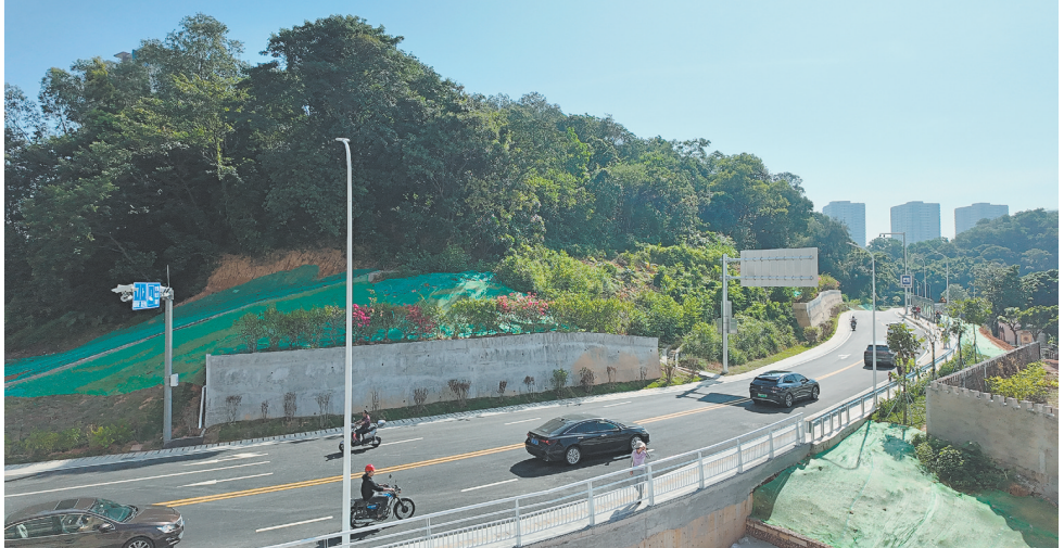
广场西路延长线南段的通车让周边居民的出行更加方便。
