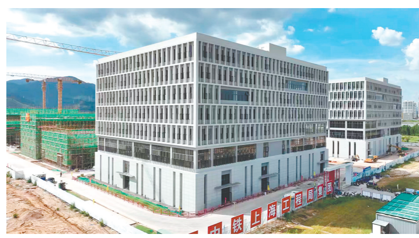
江合银湾·智造港在建实景图。
