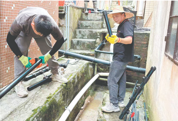
▼工作人员精准更换老化水管2520米，彻底根除管道渗水、水质浑浊的问题。双合镇供图
