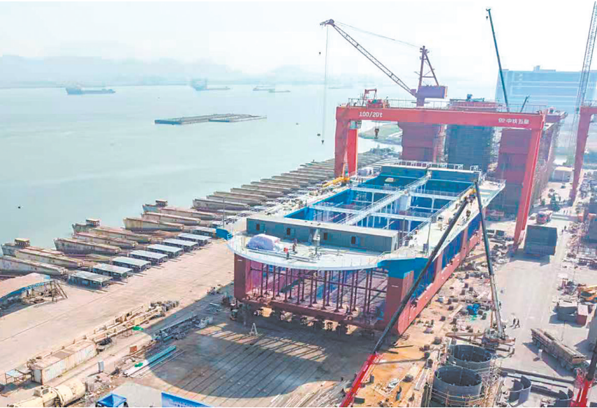
“珠海琴”由6个可自主升降的折叠式养殖网箱组成,适应15-100米水深养殖环境。
