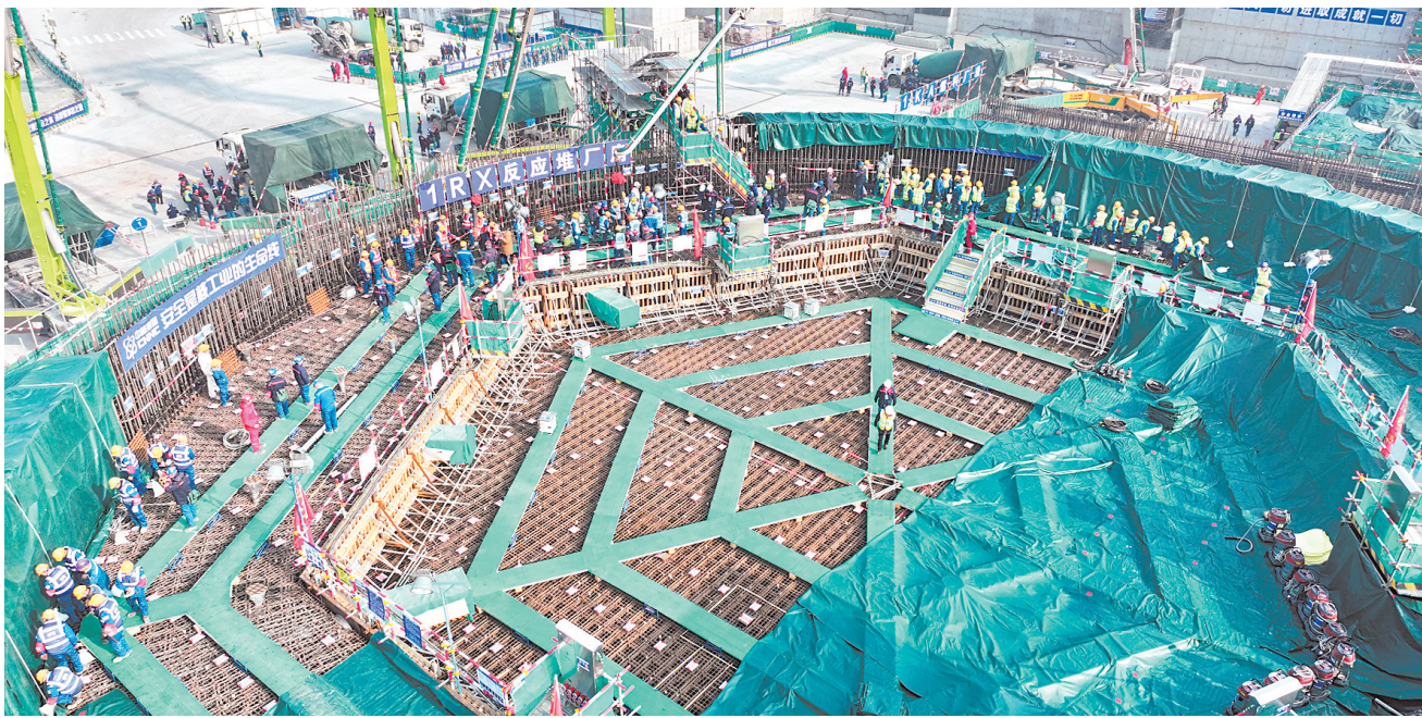
1月16日，工人在1号机组核岛浇筑混凝土（无人机照片）。新华社发
