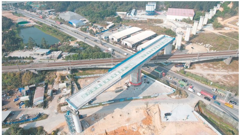
成功转体后的居安特大桥T构梁上跨广珠铁路。
