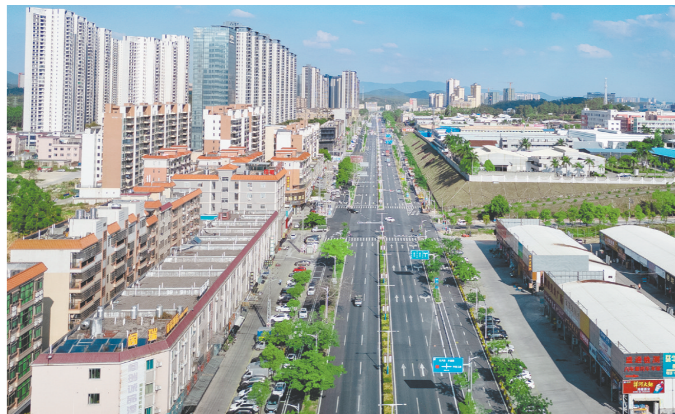
鹤山市2026年为鹤城镇安排8965万元用于典型镇、示范村建设,推进村镇规划提升、风貌塑造。
