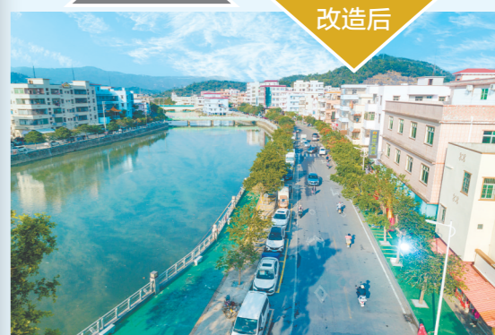
房屋外立面提升改造后,融入东南亚特色元素,打造风情浓郁、宜居宜业的特色示范主街。
