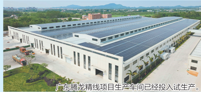
广东腾龙精线项目生产车间已经投入试生产。
