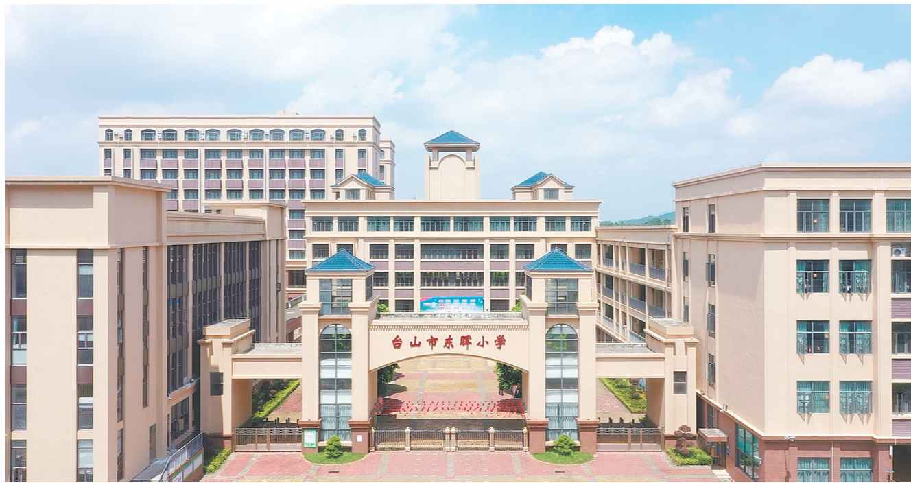
4.3万平方米的校园内，教学楼、科技楼、体育馆、报告厅一应俱全，教学区、生活区、运动区动静分离，为学生成长提供优质的硬件保障。
