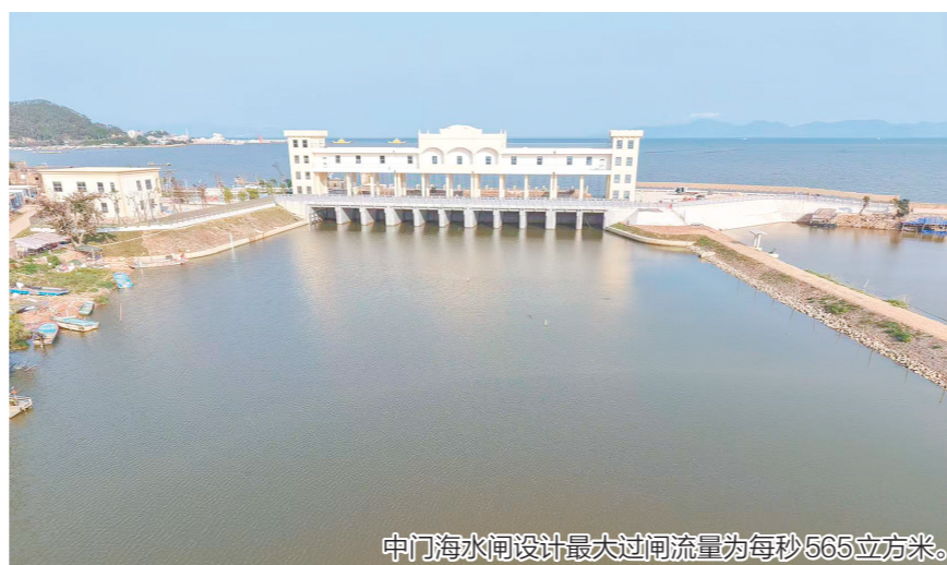
中门海水闸设计最大过闸流量为每秒565立方米。
