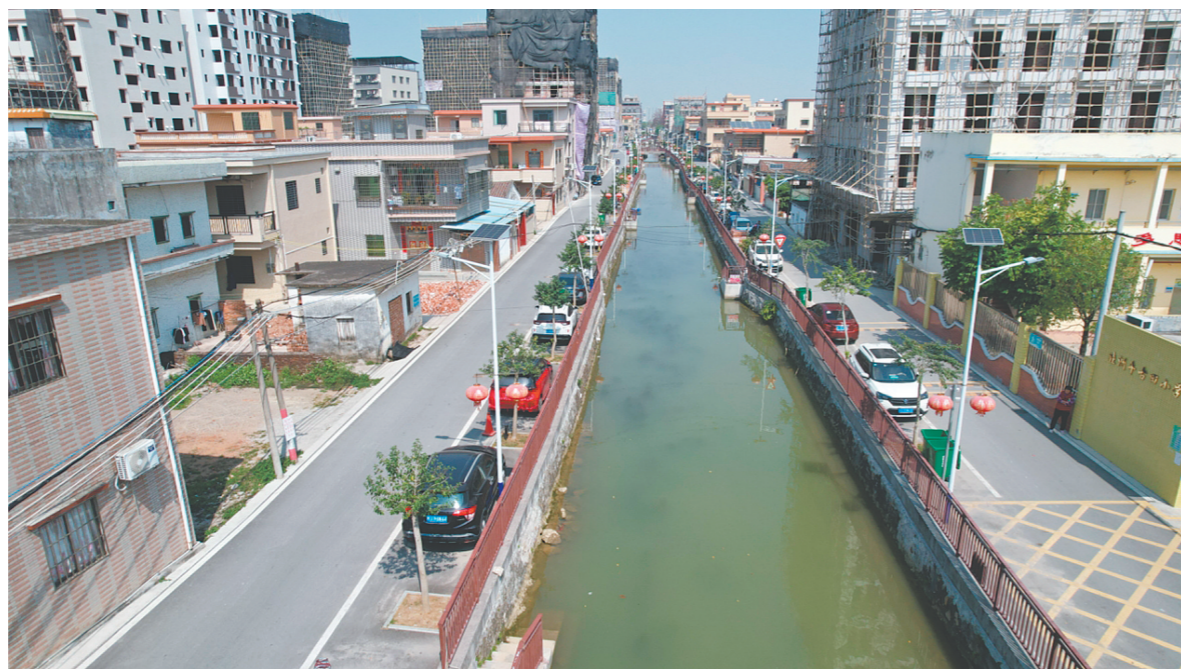
牛古田村开展一河两岸主干道品质提升工程，同步配套安装太阳能路灯和安全护栏。
