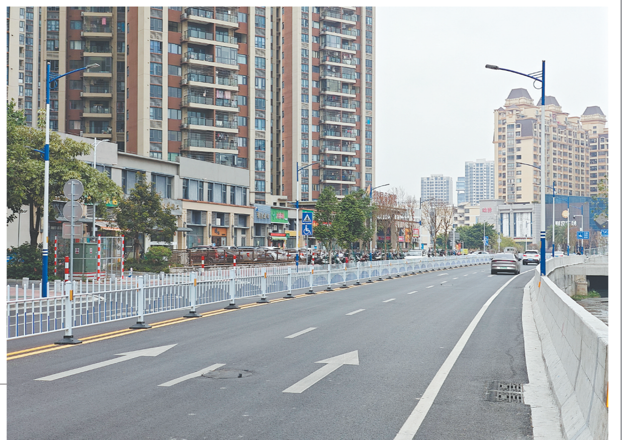
鹤山市十二号路消防大道段(财富广场一过境公路)道路工程试通车,便利周边居民出行。张舜同摄
