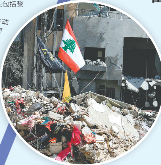
这是4月9日在黎巴嫩南部拉扎里耶拍摄的遭以色列空袭后的建筑废墟。
