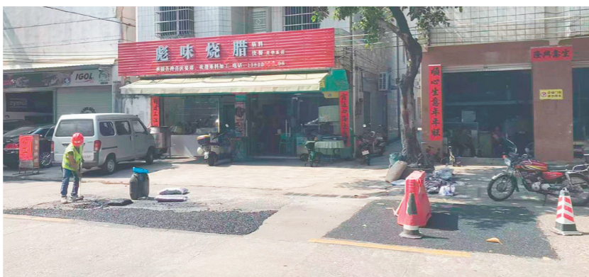
施工队伍对烧腊店前破损的路面进行填补和压实处理，消除飞石隐患。
