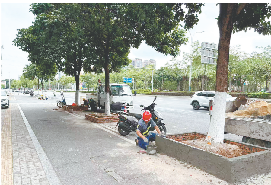
工人正在进行树池拓宽工作。
