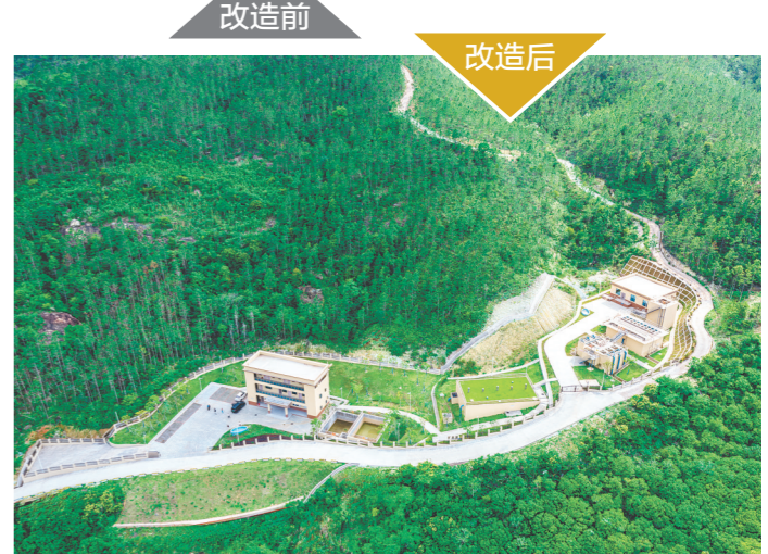
总投资近6000万元的南部水厂建成投用。日供水5000吨,配套管网68公里,1.6万名群众彻底告别“用水难”。
