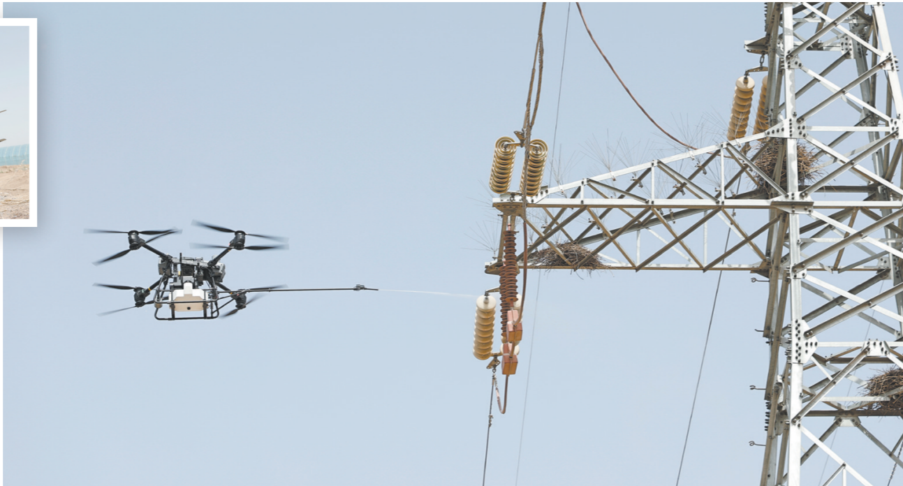
重载多旋翼无人机对110千伏沙永线70号杆塔瓷质绝缘子串开展冲洗作业(无人机照片)。
