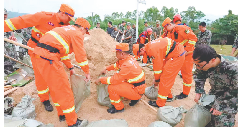
恩平开展三防应急抢险救援综合演练,进一步提升应对台风、暴雨、洪涝等灾害的防御和应急抢险救援能力。
