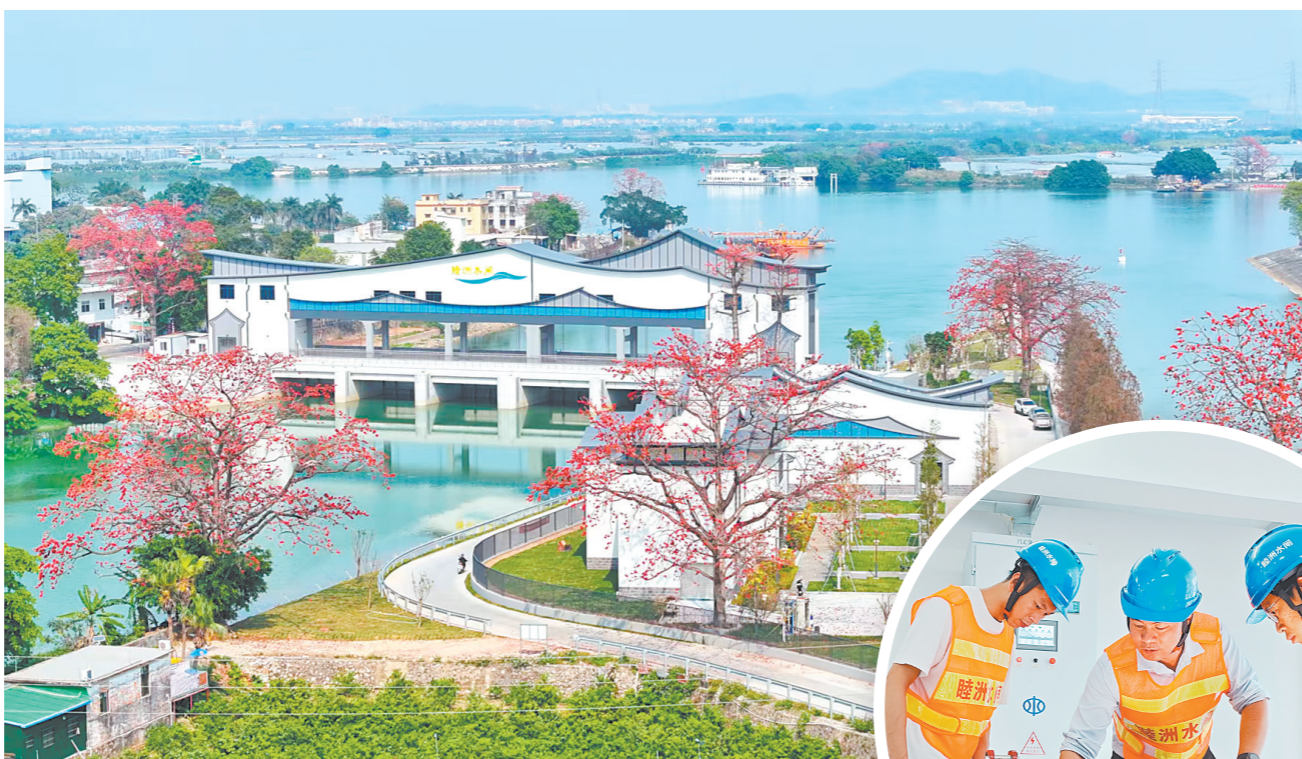
升级改造后的睦洲水闸焕然一新。
