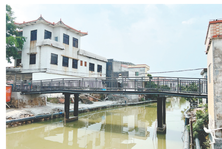
新建成的钢结构便民新桥打通了村民出行的堵点。
