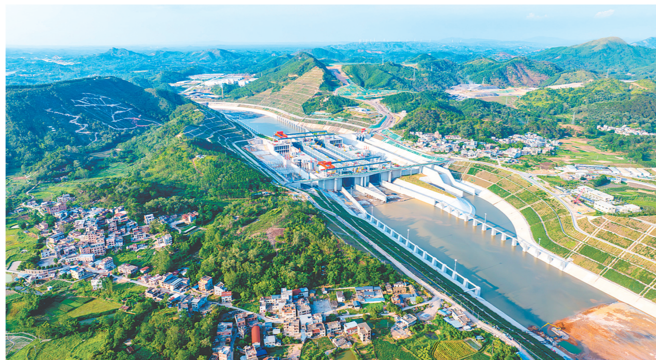
这是6月3日拍摄的广西平陆运河马道枢纽充水现场(无人机照片)。新华社发
