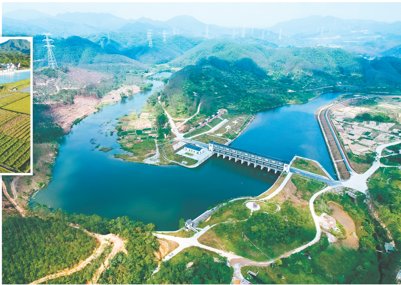
蓝田水闸。钟顺宜 摄
