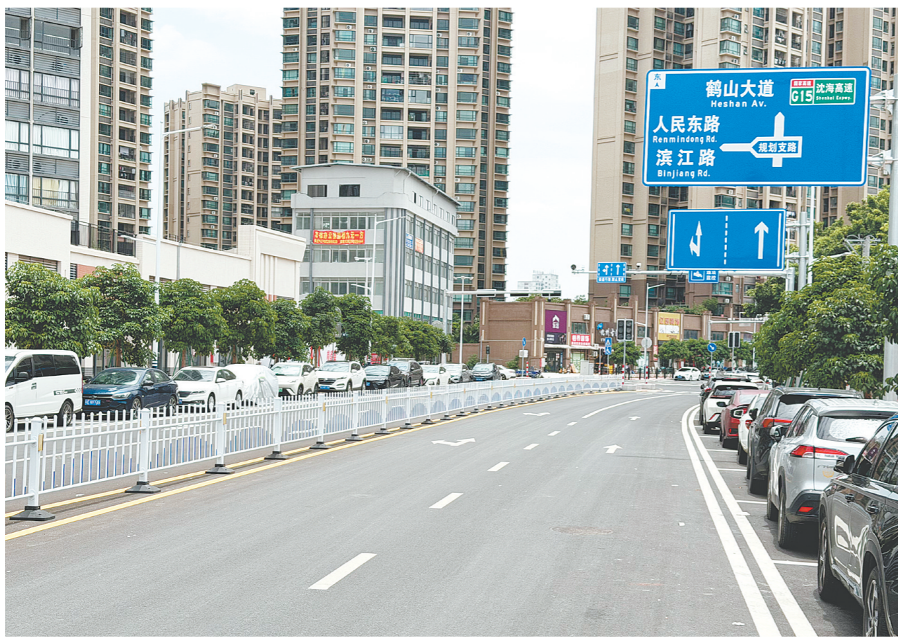
新修的道路宽阔平整，便利周边群众出行。
