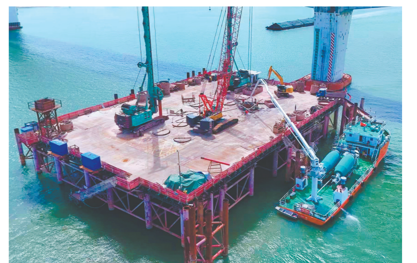
建设者对西江特大桥水上9#墩最后一根深水桩基开展混凝土灌注施工。
