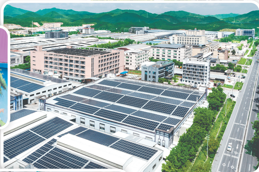
►江门市(鹤山)精细化工产业园在厂房顶部铺设分布式光伏发电系统，实现清洁能源就地生产、就地消纳。
