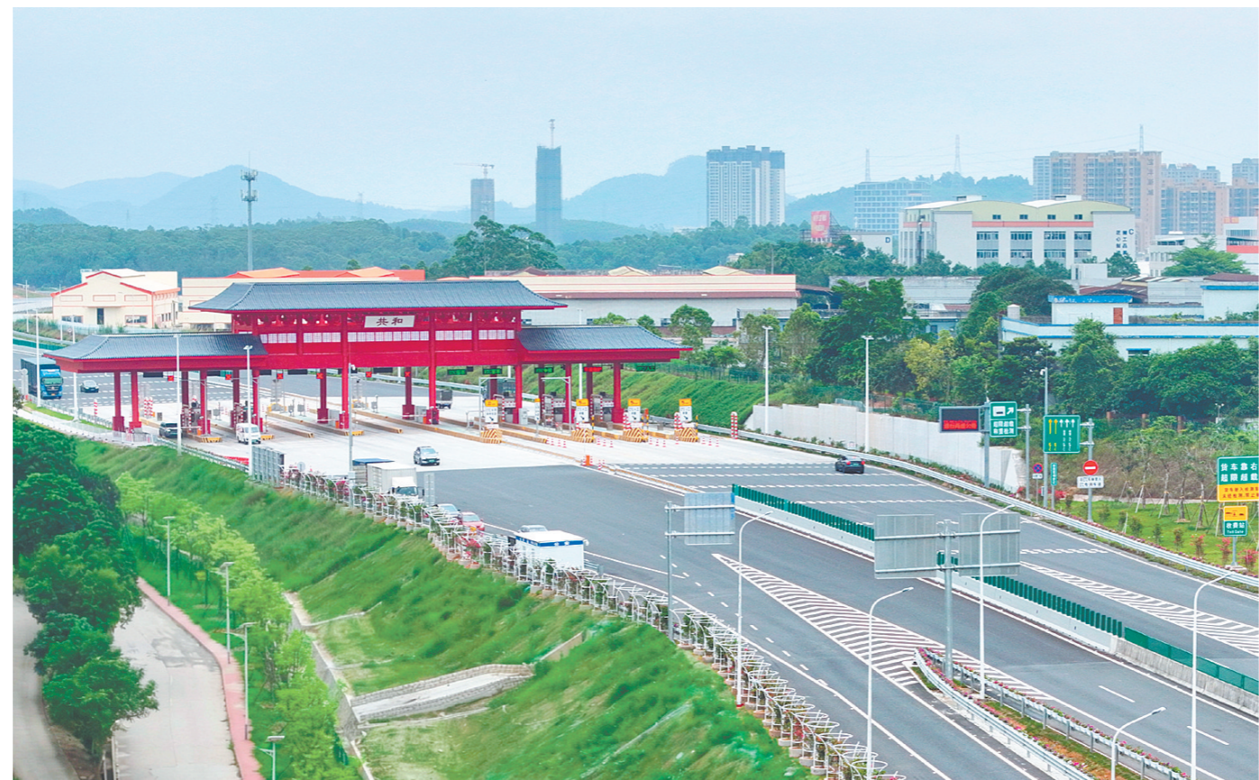
共和镇新高速出入口景观提升已顺利完成。
