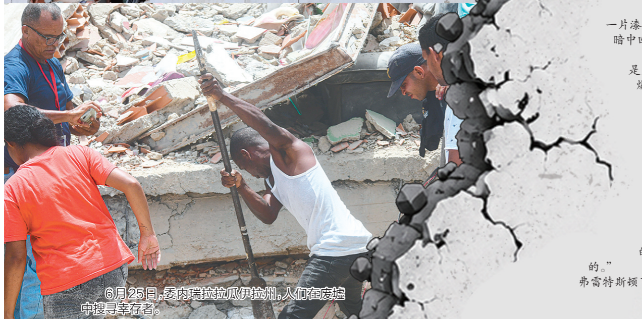
6月25日，委内瑞拉拉瓜伊拉州，居民楼在地震中严重受损。
