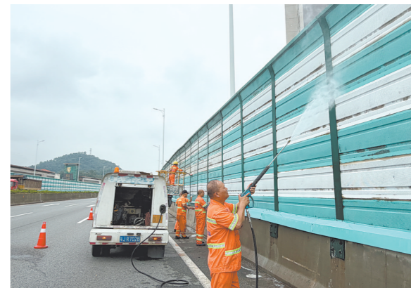
工作人员抢抓阴雨天间隙清洗隔音屏障。
