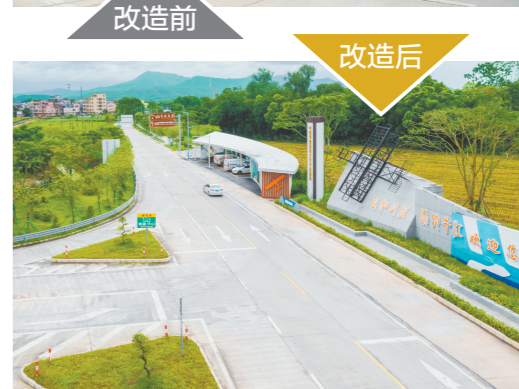
美丽乡镇入口通道配套绿化景观、特色标识等,并设置牛江驿站。
