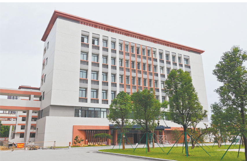
梁启超纪念中学实验学校新建教学楼、宿舍楼即将投入使用。
