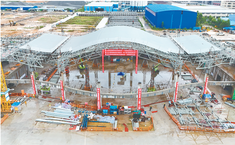
鹤山西站是珠肇高铁首座完成主体封顶的新建高铁站房。
