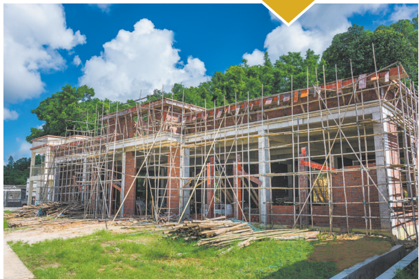
元山村在大饭堂的原址新建的文化中心正在加紧施工。
